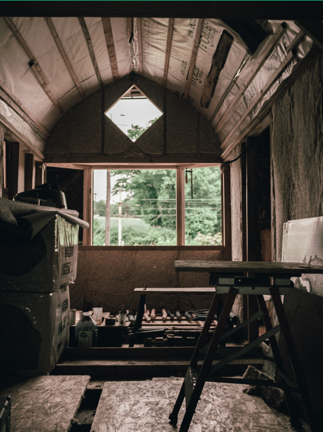
Finalisation du chantier de Rotlòta , collectif Ronce et CAC Brétigny, 2026. Photo © Brunelle Dalbavie
